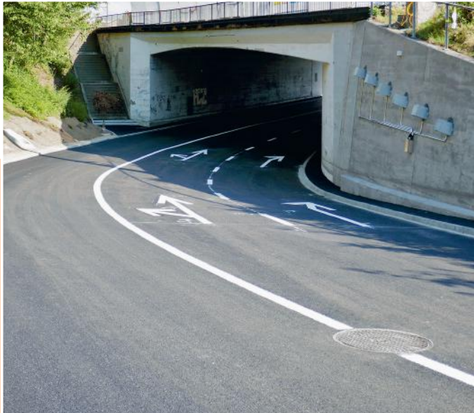
Die Hofunterführung ist wieder befahrbar
