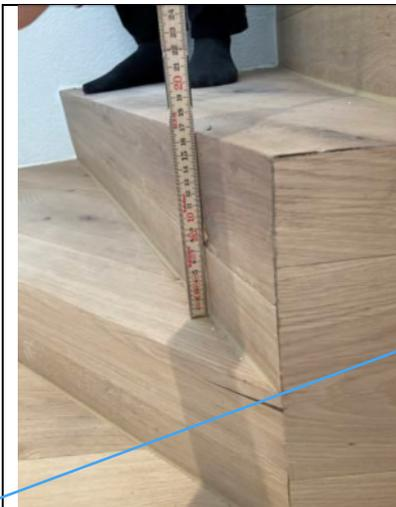
Treppenstufen sind nicht gleich hoch. Teilweise bis zu 3cm unterschied. Die stellt eine erhöhte Stolpergefahr dar, so dass sich jemand ernsthaft verletzen kann.
