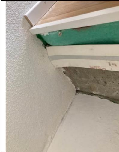
Der schwimmende Unterlagsboden ist sichtbar im „Schlupf“ unter der Treppe.
