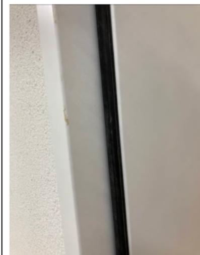
Zarge ist verschmutzt durch Abrieb sowie Silikon. Ist nachzubessern.
